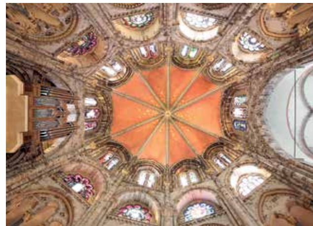
Deckengewölbe St. Gereon, Köln
