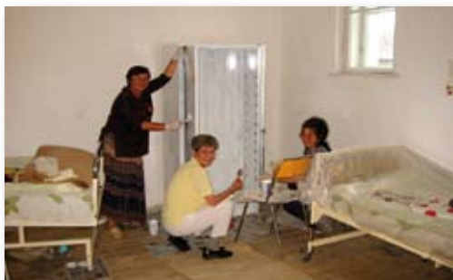
Renovierungsarbeiten in der Krankenstation
