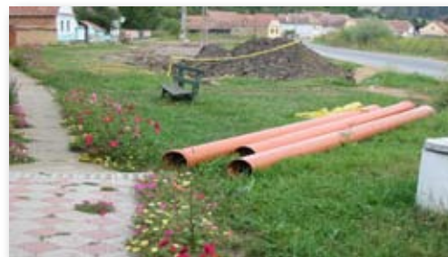
Kanalisationsarbeiten im Ort
